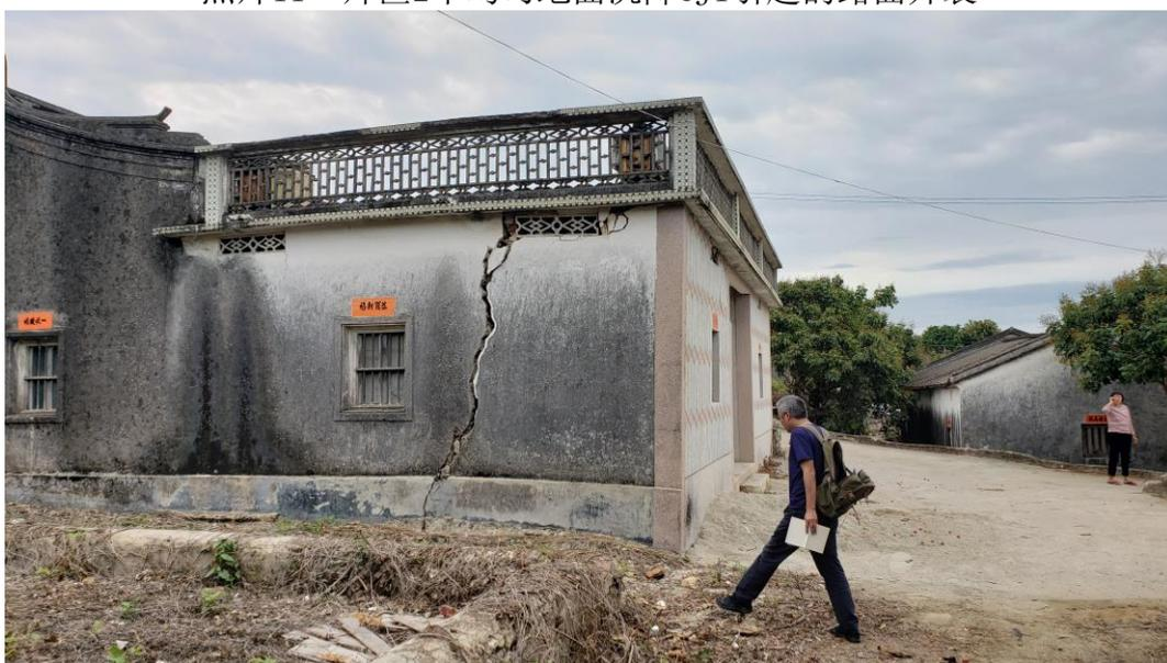
照片12 片区1不均匀地面沉降CJ2房屋裂缝照片（镜头方向40°）
