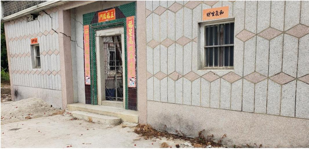
照片13片区1不均匀地面沉降CJ2房屋裂缝照片（镜头方向350°）
