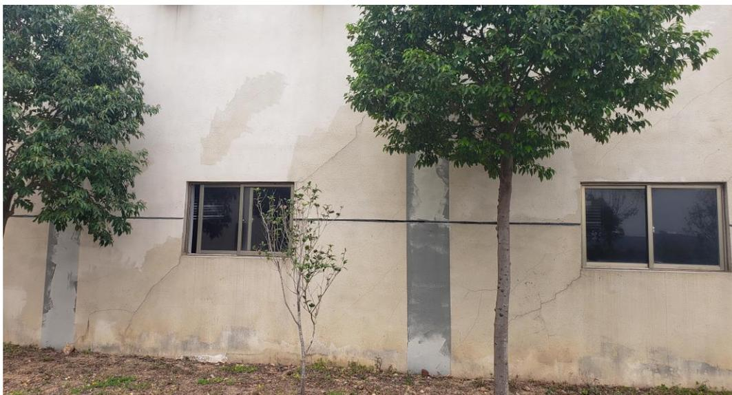
照片10 片区2不均匀地面沉降CJ1引起的墙体开裂（镜头方向190°）
