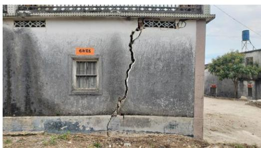
照片 3.1-3 CJ2 不均匀地面沉降房屋裂缝照片
