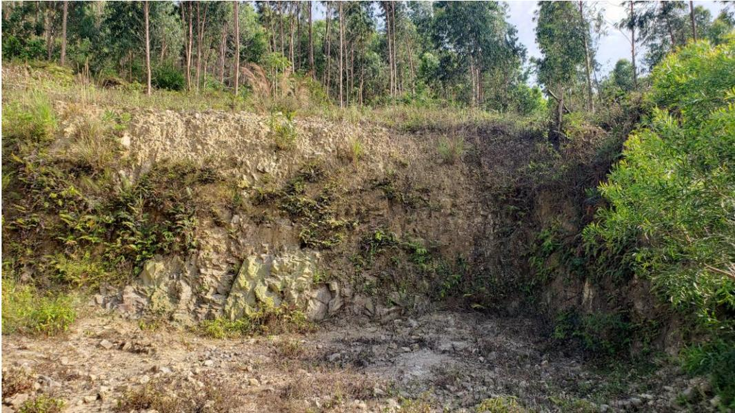
照片25 片区1东部人工岩质边坡, 晶屑熔结凝灰岩 (高度3.5m, 镜头方向25°)
