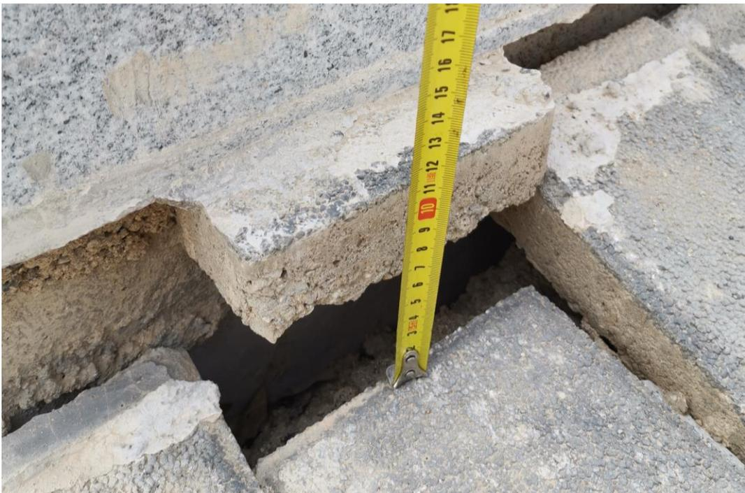
照片15 片区1不均匀地面沉降CJ3沉降最大处照片（镜头方向10°）
